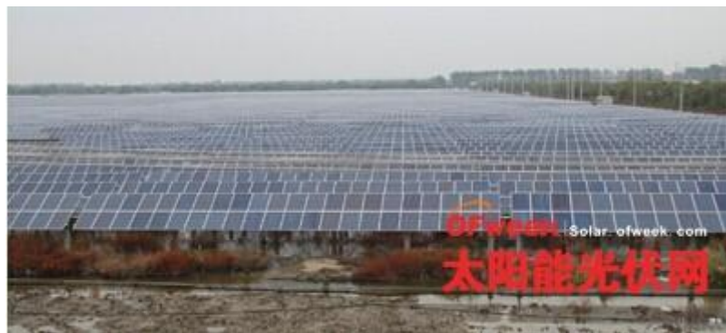
协鑫集团宝应 30MW“渔光互补”项目
